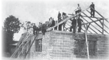
Na zdjęciu: Strażacy przy budowie przyszłej remizy, lata '50.
